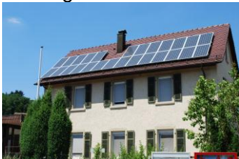
Bad Rappenau- Heinsheim, Pfarrhaus
